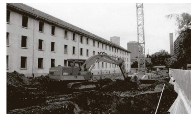
Bild links: Der Abbruch ist in vollem Gang, fein säuberlich wird der Staub weg gespritzt.
